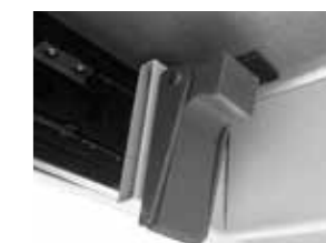
Detalle del freno del sistema de extensión. Detail of the extension system brake. Détail du frein du système d'extension. Detail der Extensionssystembremse.
